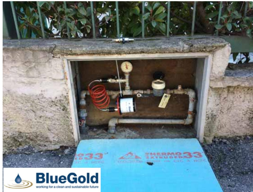
Trasduttori di pressione collegati ai contatori
